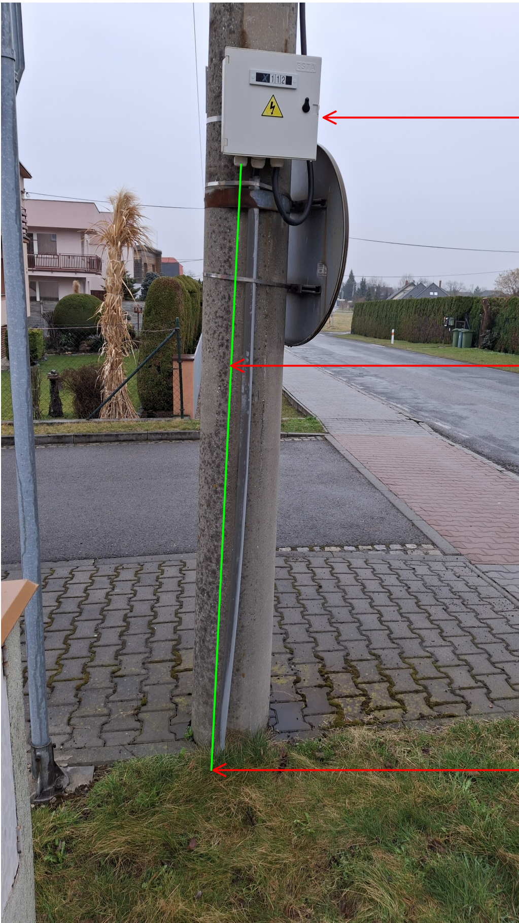
KABEL AYKY 4Bx16 UMÍSTĚN V PASTOVÉ TRUBCE TYP 4040HF_KA
