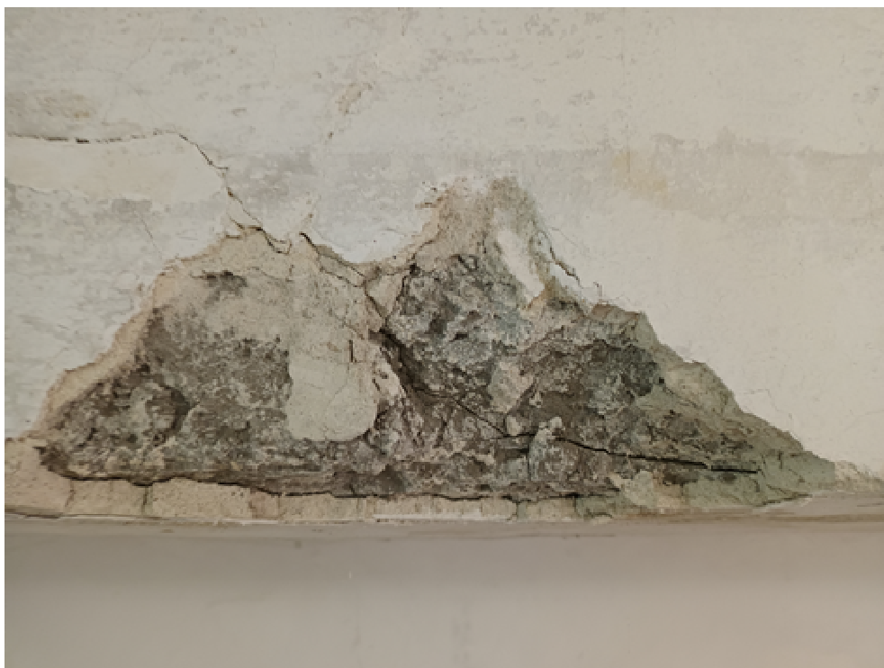
Foto 10 Sonda ke zjištění průběhu praskliny na styku stropního trámu a průvlaku - detail
