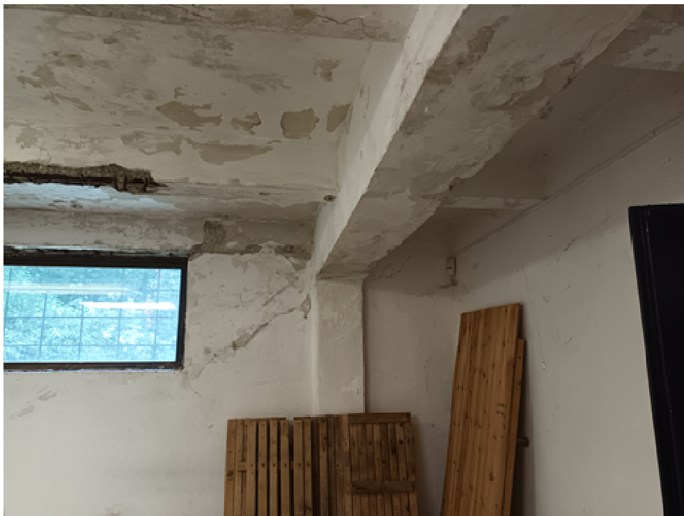
Foto 6 Styk stropního trámu a průvlaku a napojení sloupu – viditelné projevy vlhkostních poruch
