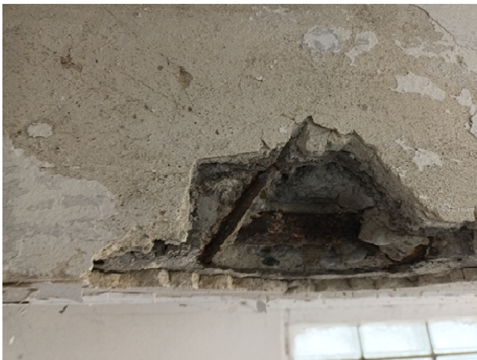
Foto 7 Sonda ke zjištění výztuže stropního trámu
