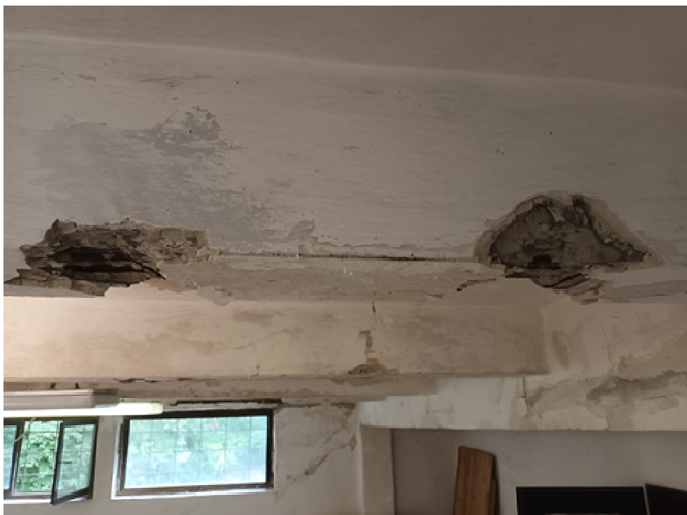
Foto 8 Sondy ke zjištění výztuže stropního trámu
