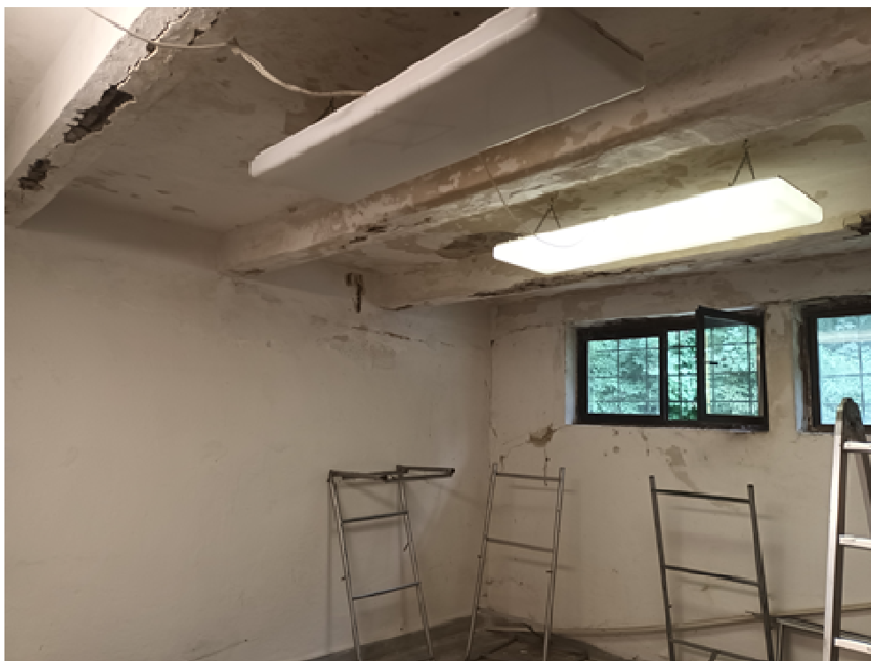
Foto 1 Stropní trámy - krycí vrstva výztuže uvolněná/odpadlá/degradovaná
