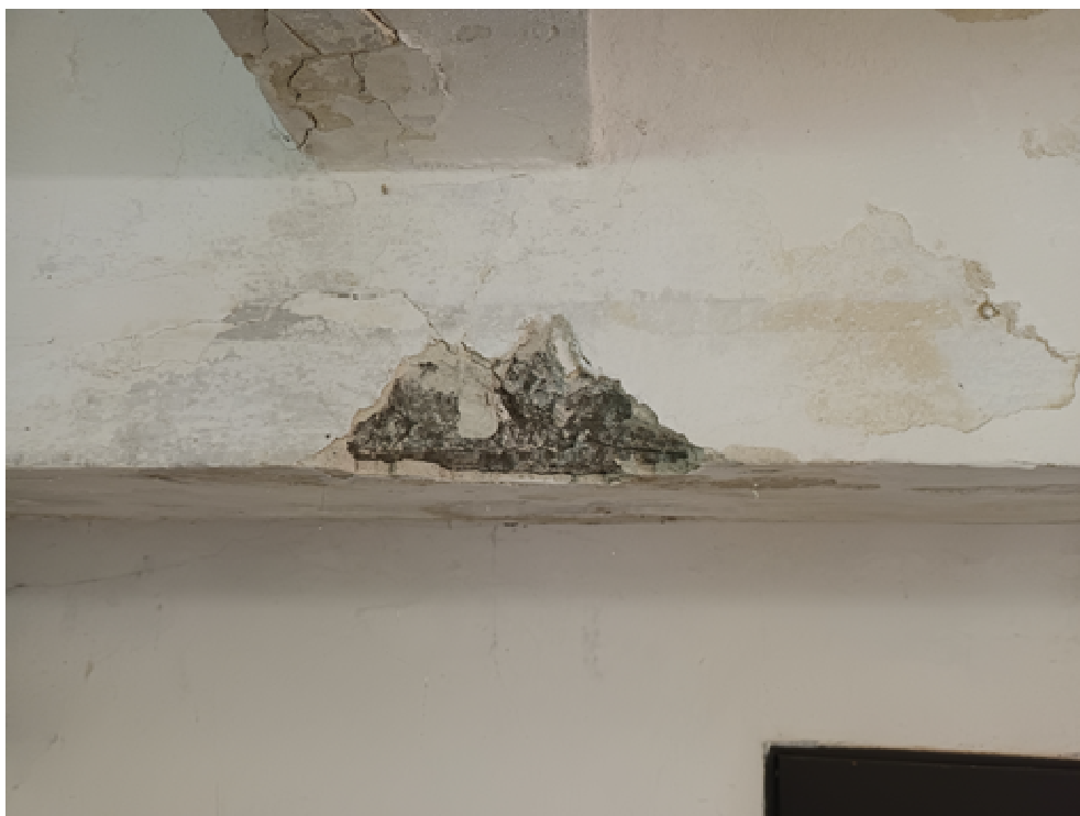
Foto 9 Sonda ke zjištění průběhu praskliny na styku stropního trámu a průvlaku
