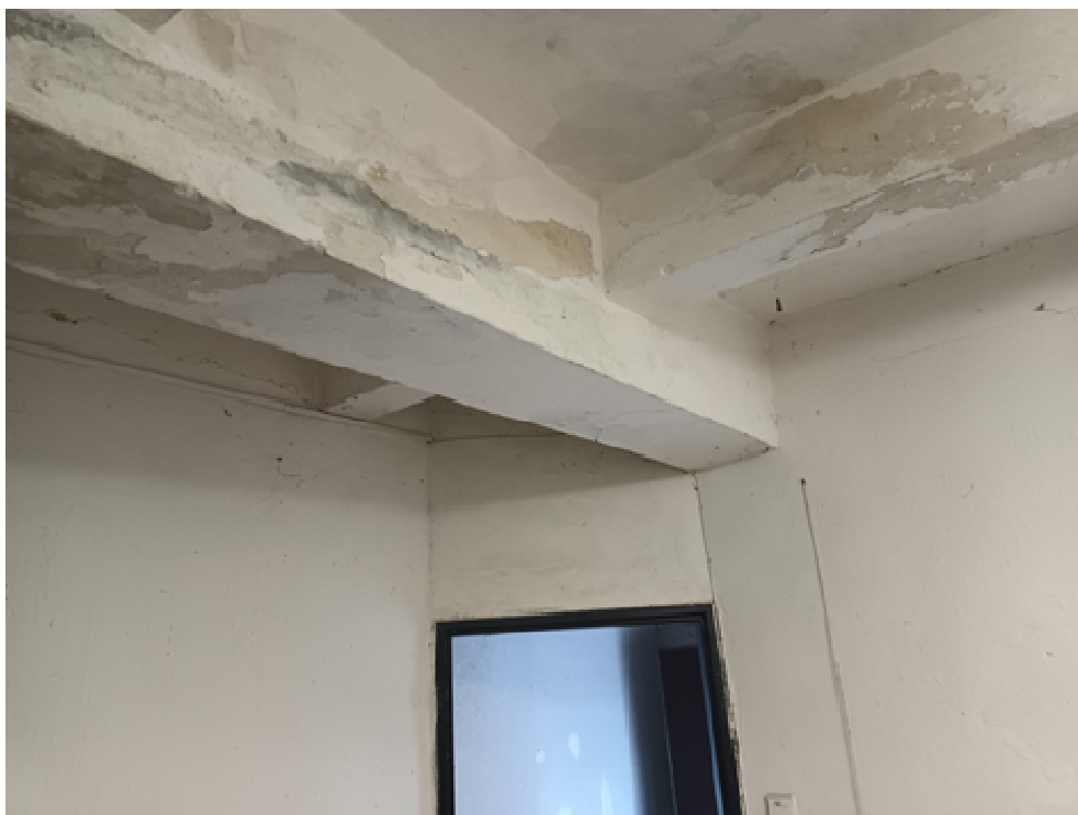
Foto 5 Styk stropního trámu a průvlaku – viditelné projevy vlhkostních poruch
