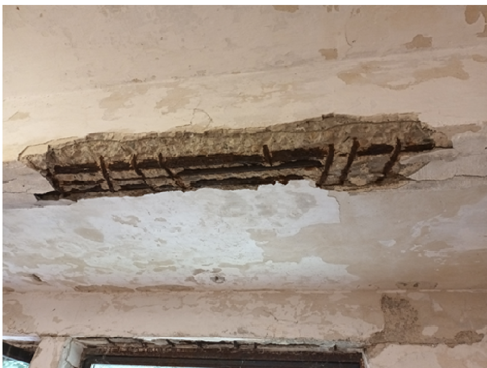
Foto 2 Stropní trám – detailní pohled na obnaženou spodní výztuž a třmínky
