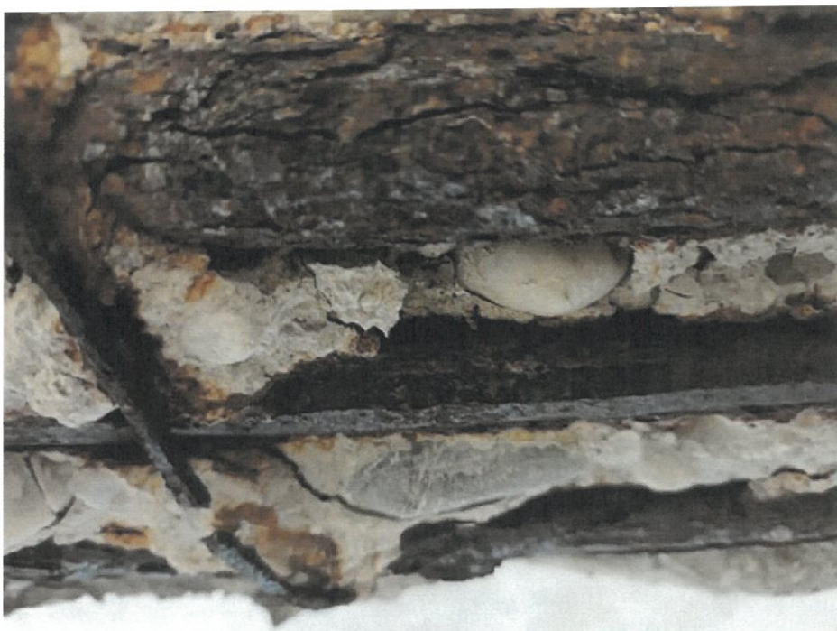
Foto 4 Stropní trám – detailní pohled – výrazné korozní úbytky spodní podélné výztuže
