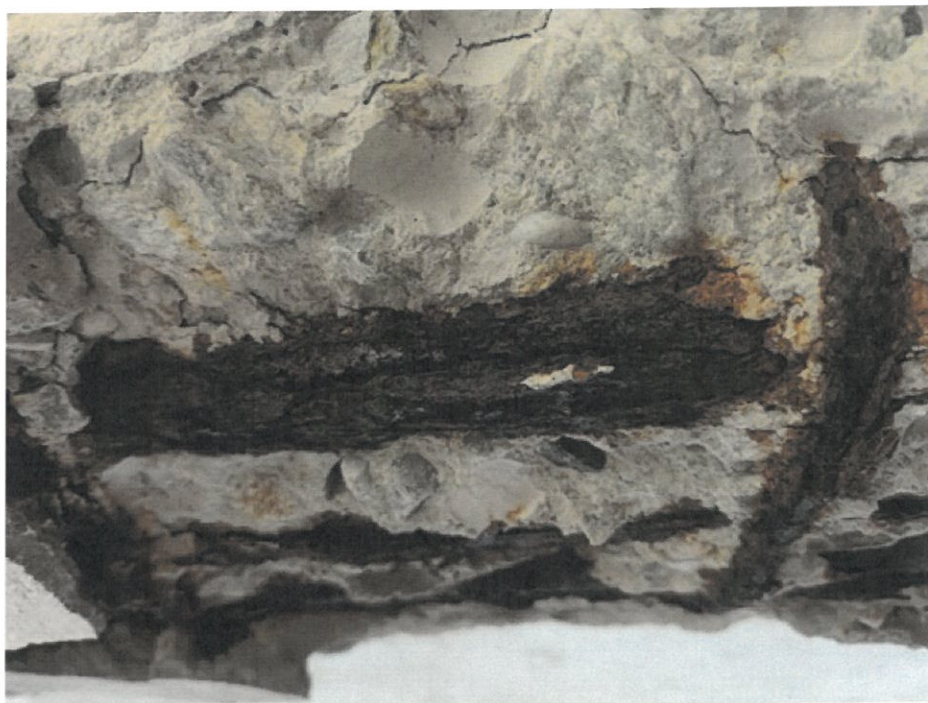
Foto 3 Stropní trám – detailní pohled na obnaženou spodní výztuž a třmínky
