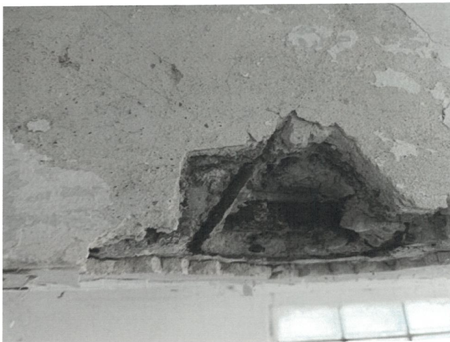
Foto 7 Sonda ke zjištění výztuže stropního trámu
