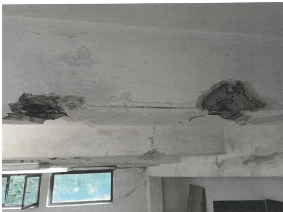
Foto 8 Sondy ke zjištění výztuže stropního trámu
