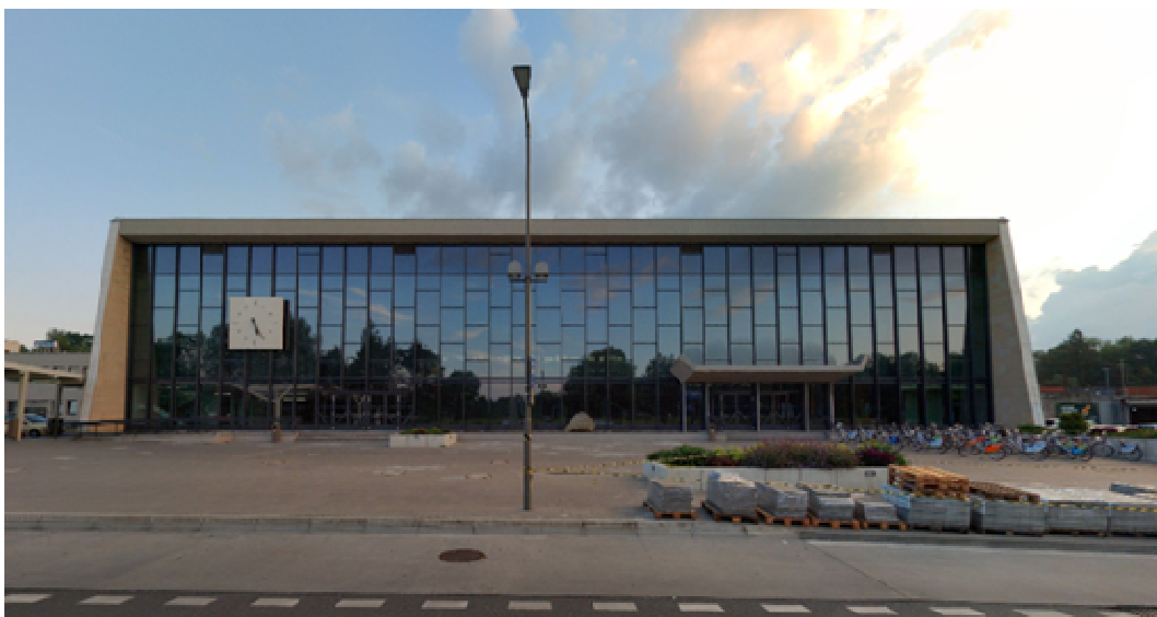
Obr. 1 Sportovní hala – celkový pohled
