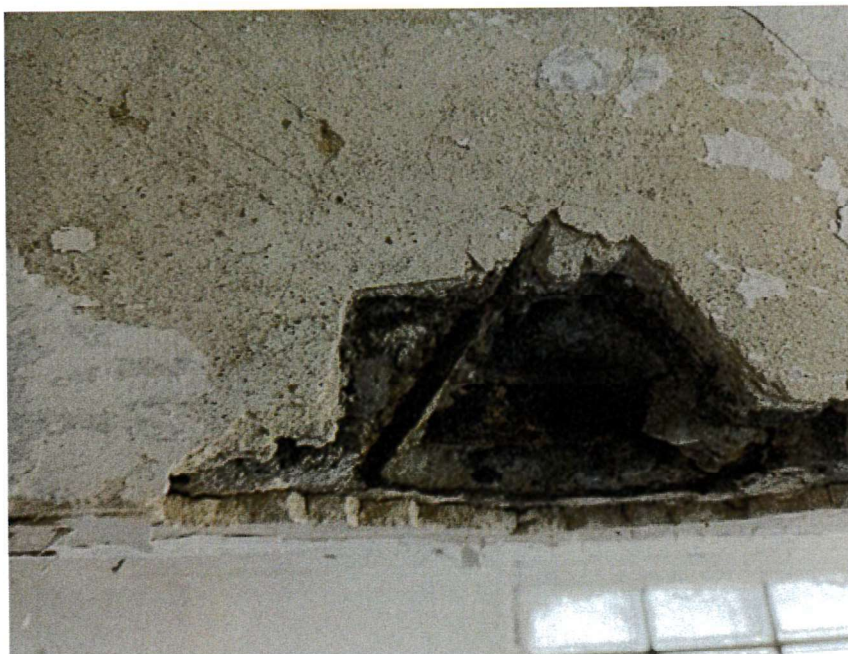
Foto 7 Sonda ke zjištění výztuže stropního trámu
