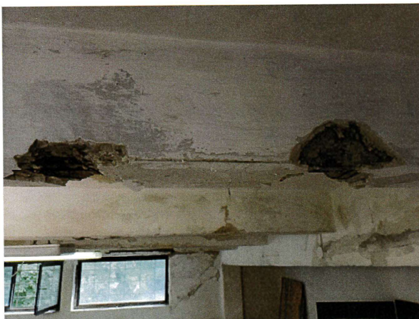
Foto 8 Sondy ke zjištění výztuže stropního trámu
